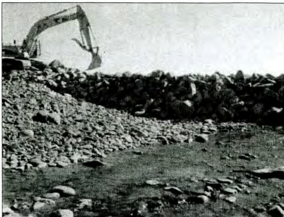
PHOTO 15 Stabilisation des ponceaux au moyen d'empierrements (route Donaldson - Mesamax).
