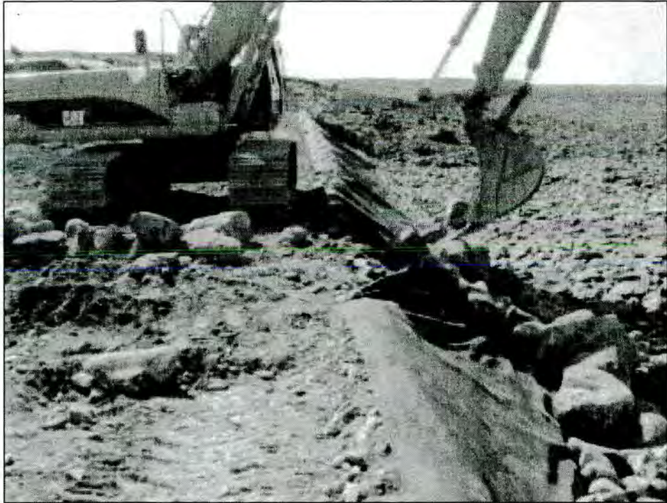
PHOTO 13 Stabilisation des talus au moyen d'une géomembrane au droit des traversées de cours d'eau (route Donaldson - Mesamax).
