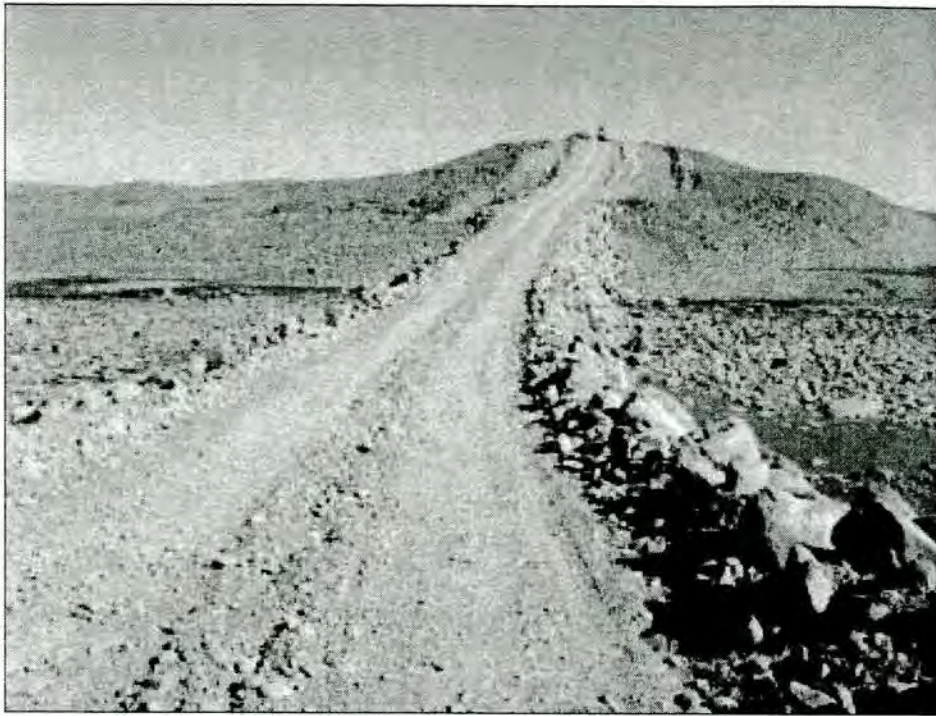
PHOTO 11 Exemple de fossé interrompu à proximité d'un cours d'eau (route existante reliant le site Mesamax et l'aéroport de Donaldson).
