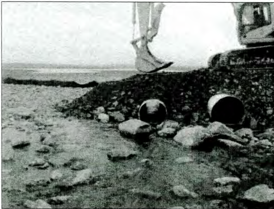
PHOTO 12 Utilisation d'une géomembrane en aval des points de traversée (route Donaldson - Mesamax).
