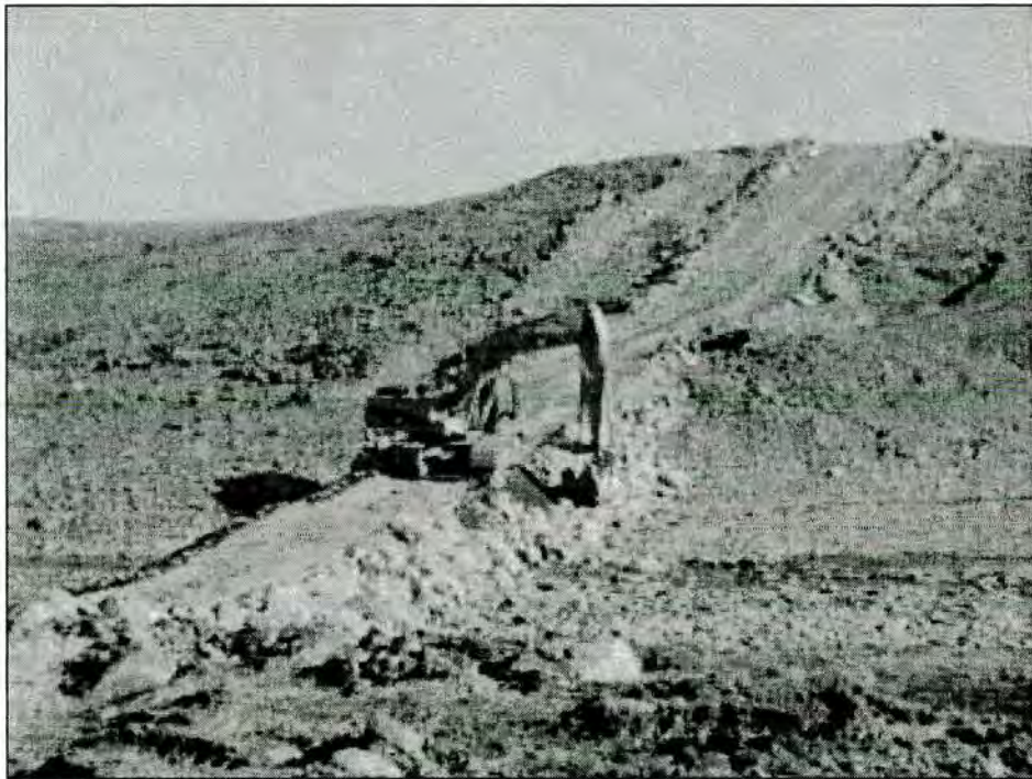
PHOTO 14 Stabilisation des talus de la route reliant l'aéroport de Donaldson à Mesamax.
